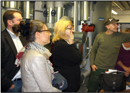
Bei Familie Prell steht mit dem Heizkessel das Herzstück des Fernwärmenetzes
